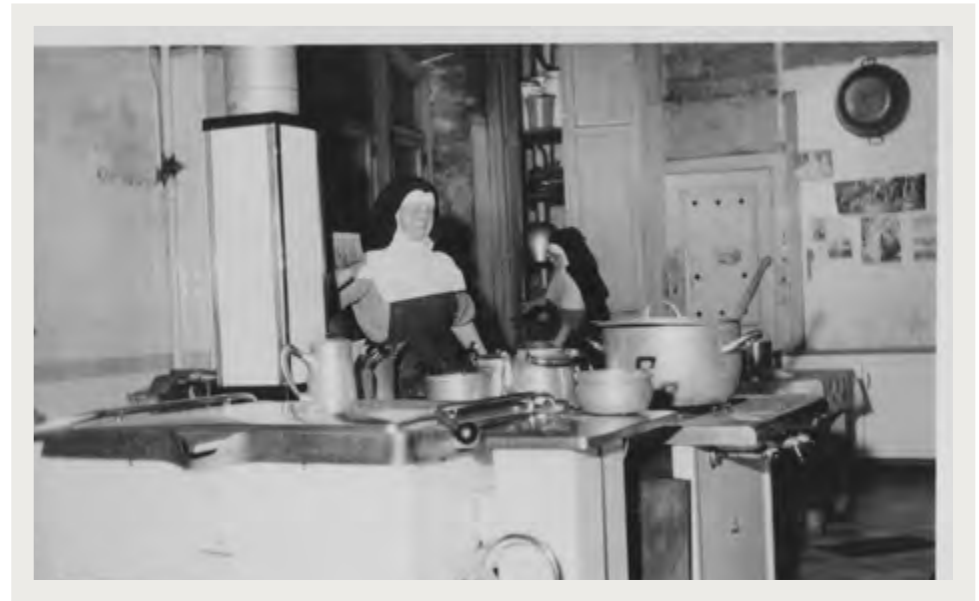
Cuisines au sous-sol.
