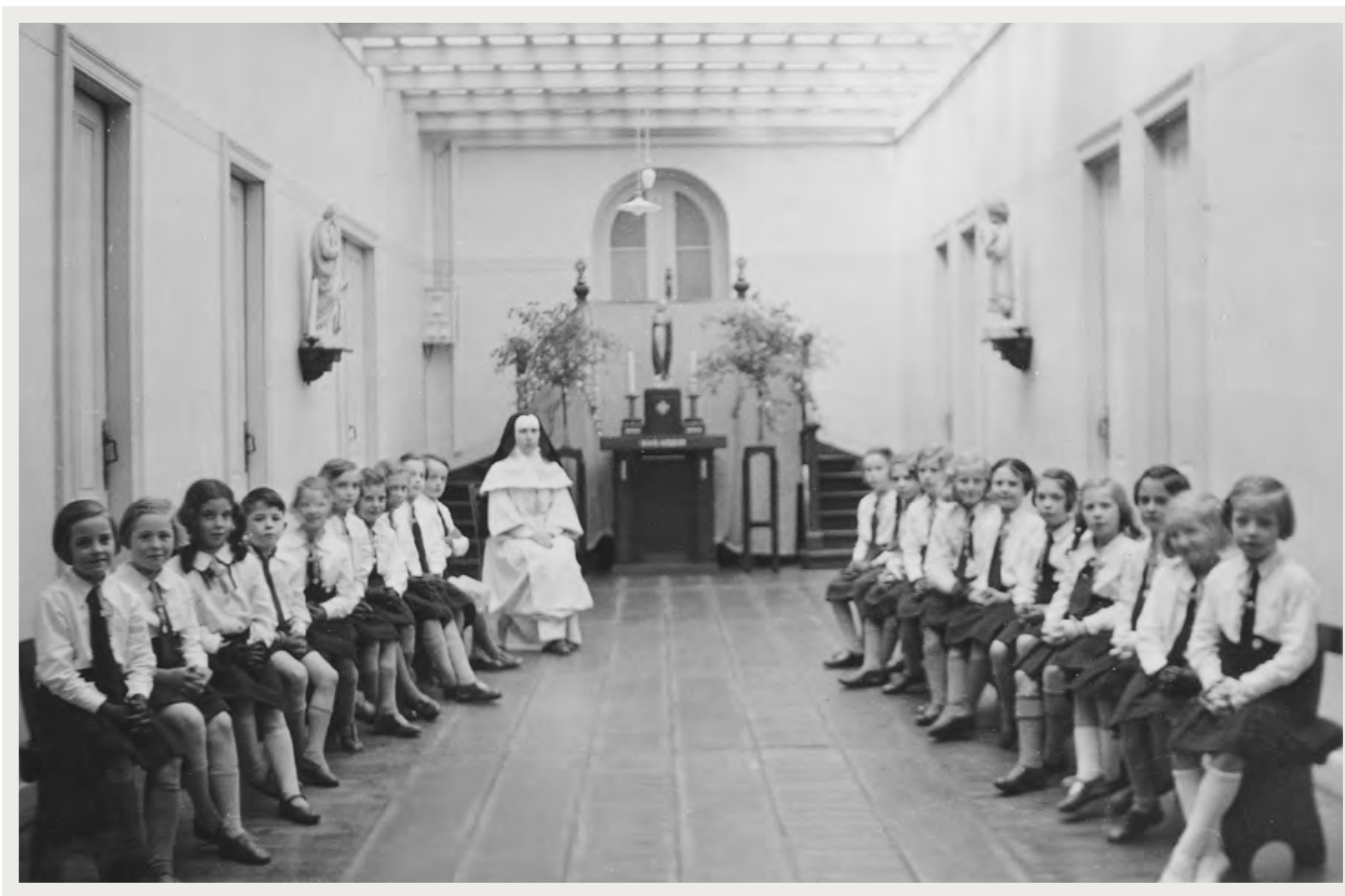
Hall du 3 e étage.
